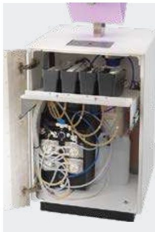
Fig. 8: Caisson de la station AQA essenza 30+4 (vue intérieure)
